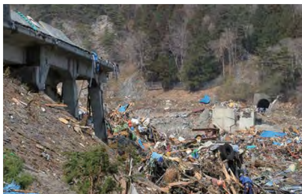
流出した島越駅と高架橋
