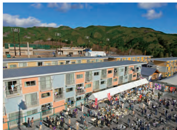
コンテナ多層仮設住宅プロジェクト 海上輸送用コンテナ / 2011 [宮城県]
