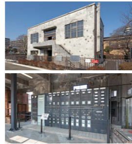
旧日立航空機株式会社変電所とその内部【東大和市】6年 p.212
