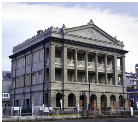
▲ 旧香港上海銀行長崎支店（国重要文化財）
