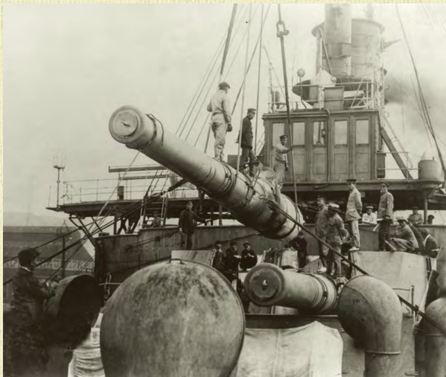
▲ 軍縮条約締結後に武装撤去が決まり、30センチ砲が取り外される戦艦敷島（1923年撮影、提供 朝日新聞社）
