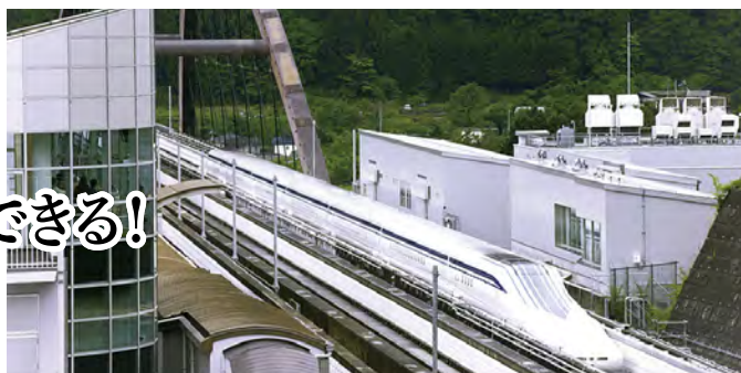
▲ 走行試験を行うリニア車両を間近で見学 (走行試験のスケジュールは見学センター HP にてご確認ください)
