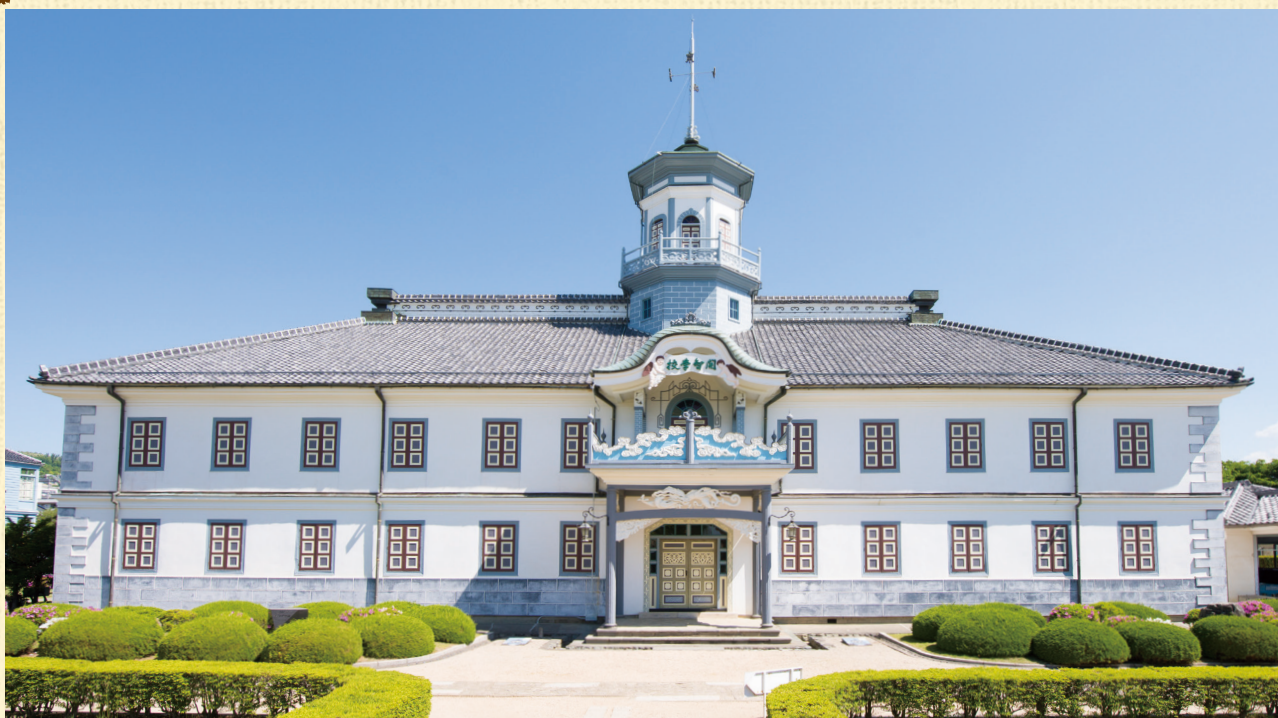
▲校舎全景：左右対称（シンメトリー）になっていないのも擬洋風建築らしい点である。
