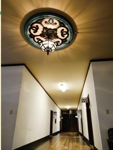
▲内部廊下：中廊下の造りは、現在主流の片廊下と比べると日当たりに難があるも、明治初期に廊下でしっかり全教室を独立させた点が評価される。
