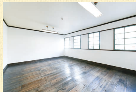
▲教室：3間×4間で天井高は10尺（約3m）。当時の校舎の中ではかなり広めの造りとなっている。
