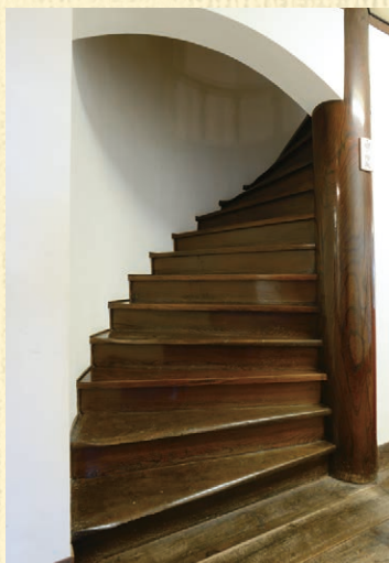
▲回り階段：お寺から転用されたという丸柱を中心に造られている。非常に急な造りだが内部の洋風ポイントの一つである。
