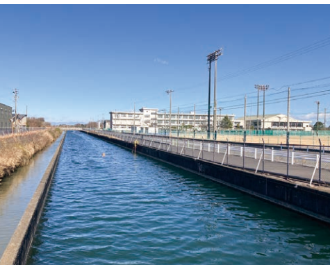
1 海部幹線水路(愛西市江西町)
