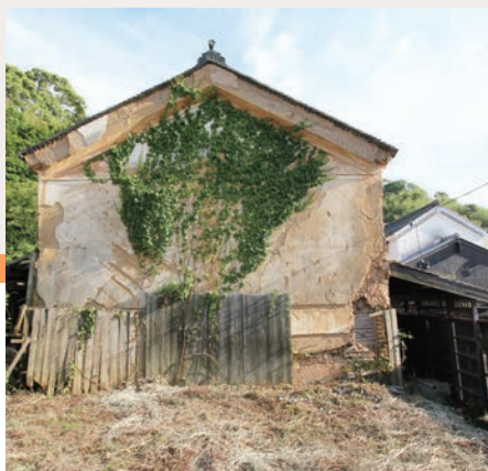
▲ 取り壊しが予定されていた建物
