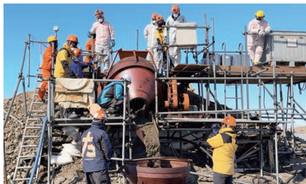
▲ 職種を超えてコンクリートを協力してつくる
