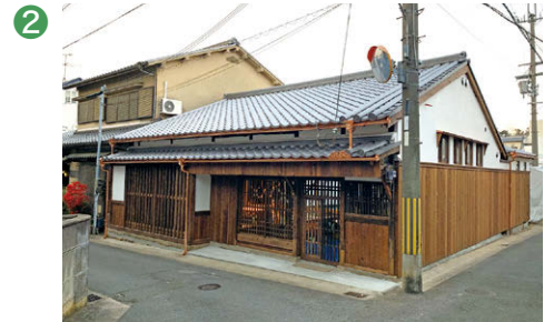
2 奈良市が修理費の一部を補助した町家 (2019年 奈良県奈良市)
